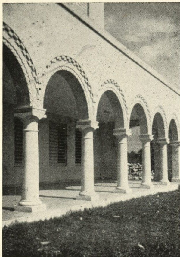
Patio mostrando las hermosas columnas y arcos romanos.
