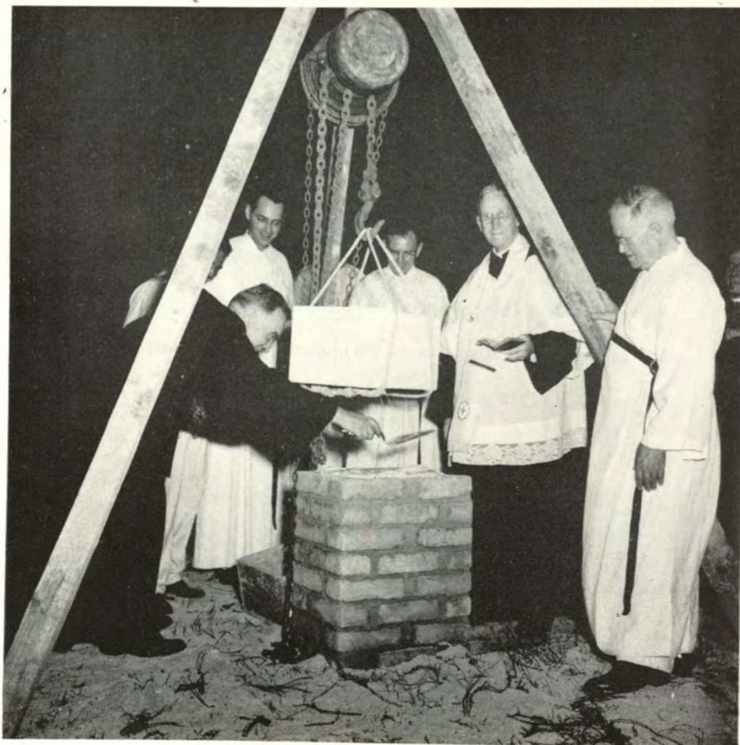
COLOCANDO LA PRIMERA PIEDRA...
