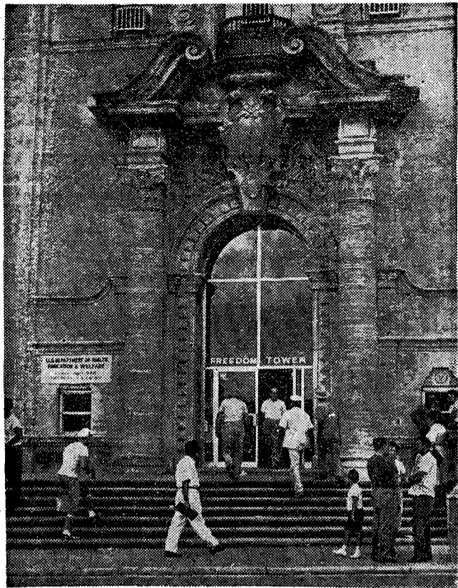
La Nueva Sede del Centro de Refugiados
