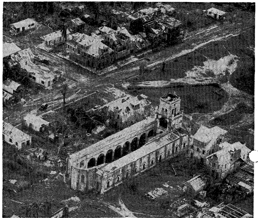
ESTA IGLESIA perdió totalmente el techo y sufrió otros daños como consecuencia de la fuerza con que el huracán Flora azotó a Haití. Otras muchas iglesias sufrieron daños de consideración. La foto recoge también el estado deplorable de otras edificaciones des-
