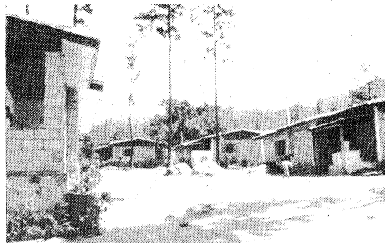
La Aldea Infantil de San Francisco en Construcción
